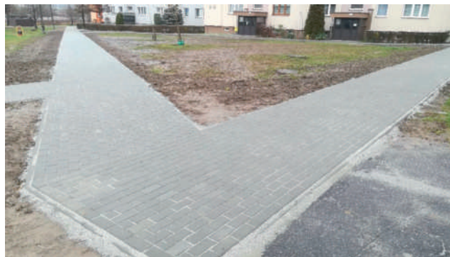
Chodnik przy ul. Braci Pisko 8-14
